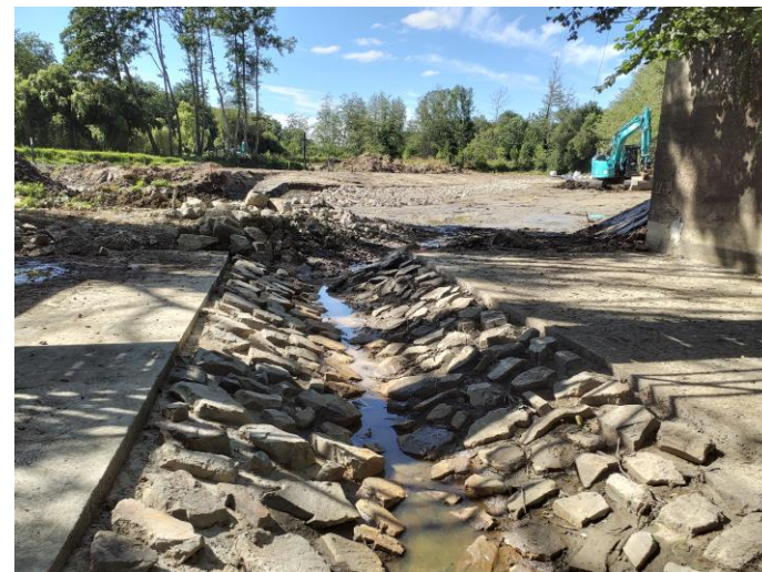
Réalisation d'une échancrure dans l'ancien radier
